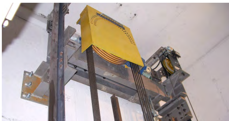
Zdjęcia wciągarek w nadszymbiu w dźwigu bez maszynowni
