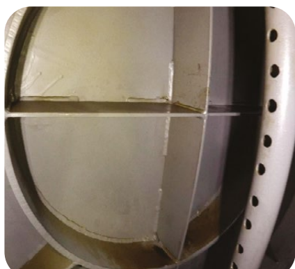
Zdj. 6. Obrazy z kamery drona przedstawiające typową rewizję wewnętrzną zbiornika podzielnego na stacji paliw (dwie komory)
