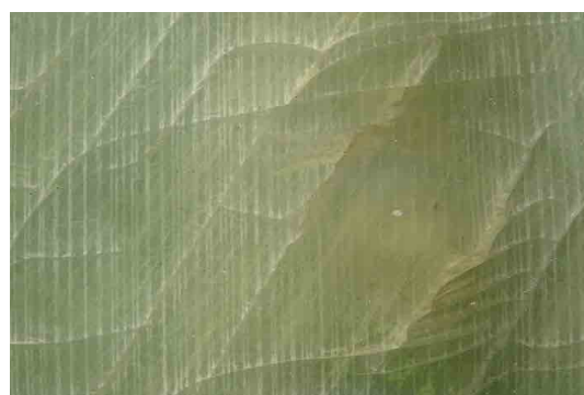
Rys. 1. Zdjęcia VT uszkodzonego laminatu
