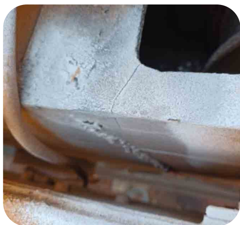
Rys. 3. Pęknięcie konstrukcji czołownicy
