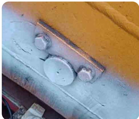
Rys. 4. Pęknięcie konstrukcji czołownicy
