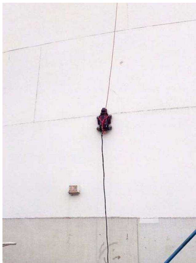
Rysunek 5. Profilowanie grubości płaszcza zbiornika – Scorpion 2
