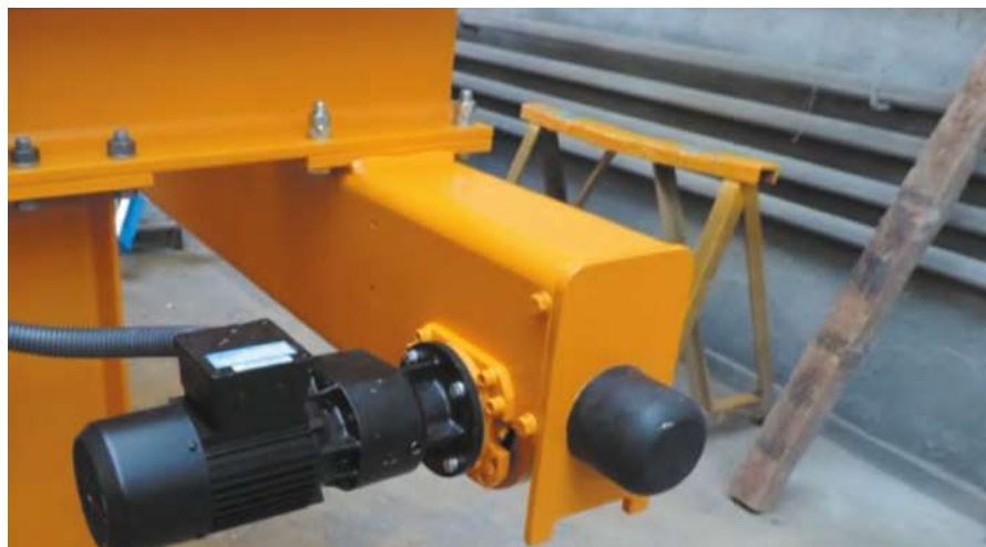
Rysunek 5. Połączenia śrubowe w konstrukcji suwnicy
