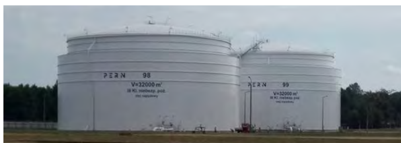
Rys. 1. Zbiorniki bezcisnieniowe, walcowe o osi pionowej, przeznaczone do magazynowania materiałów ciekłych zapalnych – widoczny dach stały o konstrukcji kopułowej oraz płaszcz zewnętrzny [1]
