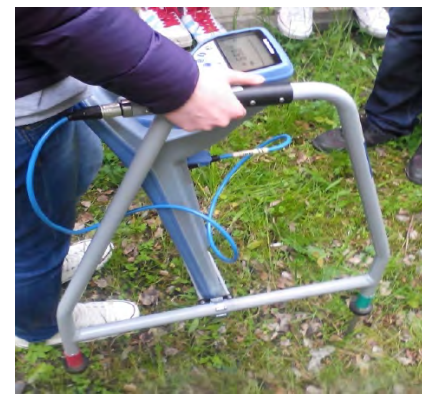
Zdj. 2. Lokalizowanie defektów izolacji rurociągu podziemnego metodą ACVG [4]
