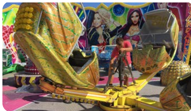
Rys. 5. Częściowy demontaż karuzeli (zdj. M. Klahs)
