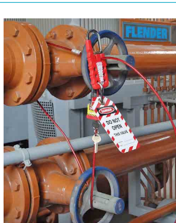
Rys. 4a. System LOTO na zaworze odcinającym [https://www.lockout-tagout.com/product/cable-lockout/ - dostęp: 11.2024]
