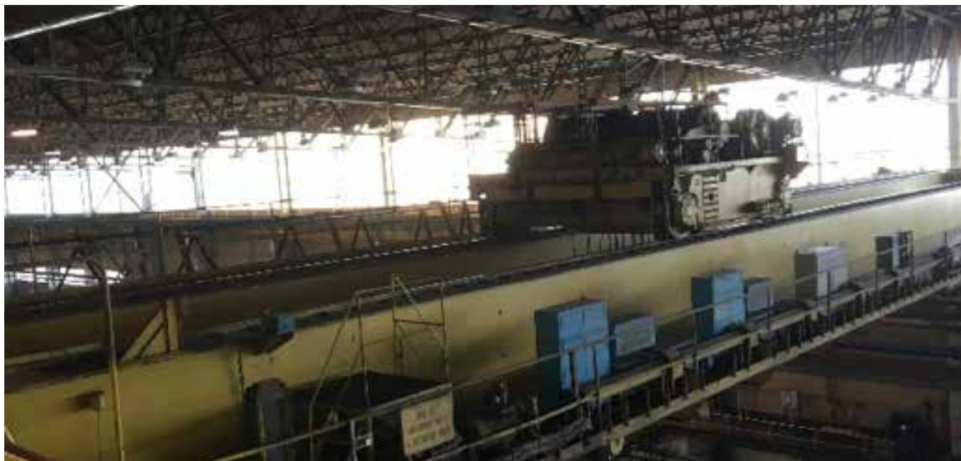
Rys. 2. Badana suwnica – widok od strony galerii
