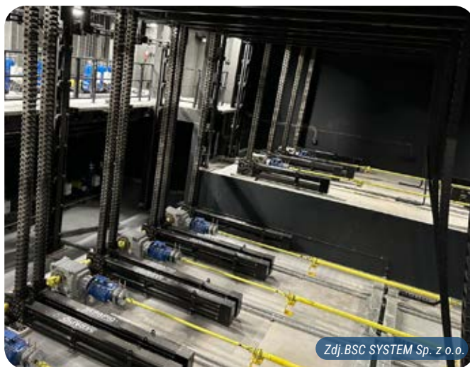
Rys. 15. Zapadnia sceniczna z napędem technologii sztywnego łańcucha
