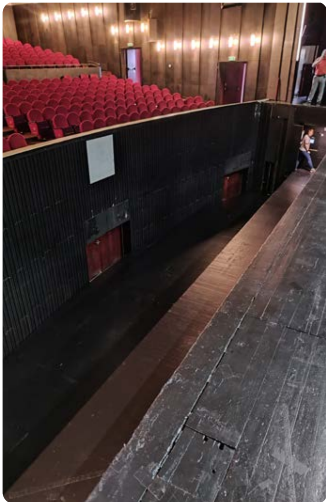
Rys. 13. Zespół dwóch zapadni fosi orkiestrowej
