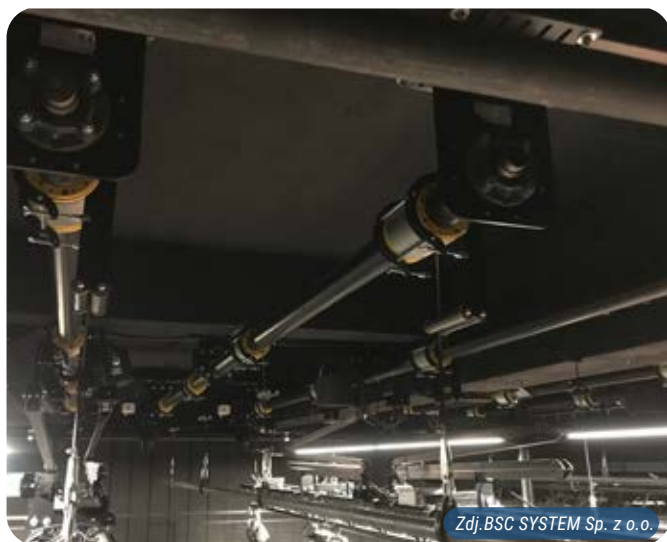
Rys. 5. Wciągarki linowe – wałowe
