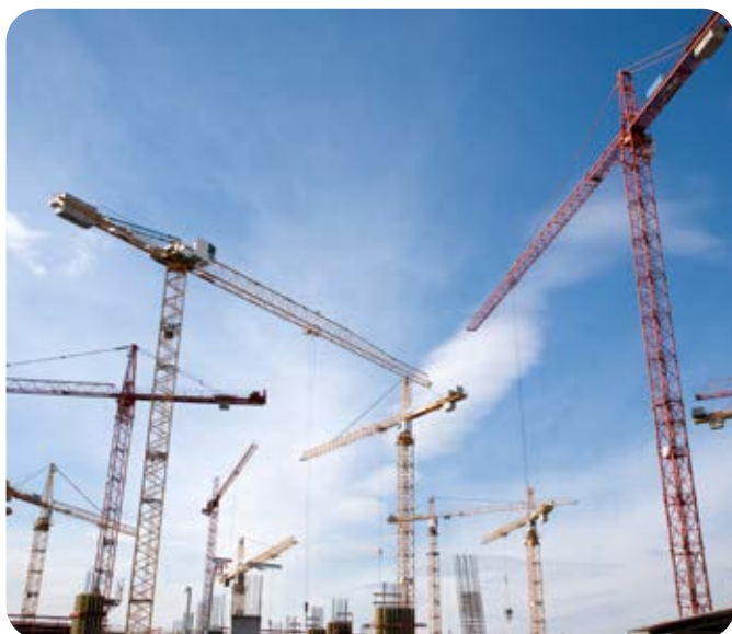
Rys. 7a. Żuraw wieżowy
