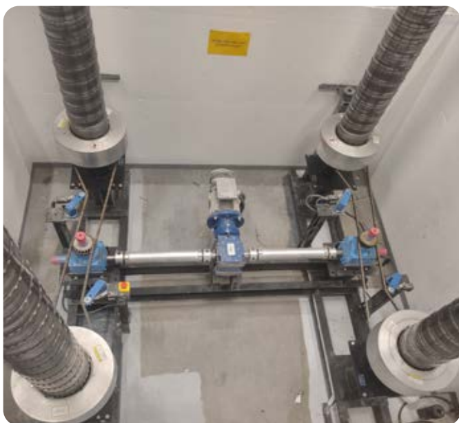
Rys. 14. Zapadnia sceniczna z napędem kolumny spiralnej
