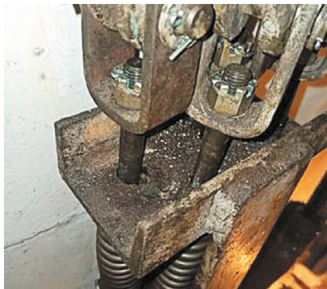
Rysunek 7. Przykład połączenia sworzniowego na linach nośnych zawieszania kabiny lub przeciwwagi
