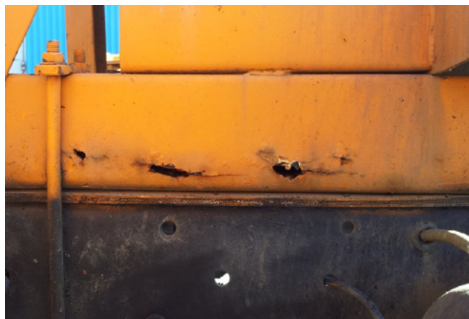
Rysunek 2. Ubytki korozyjne konstrukcji
