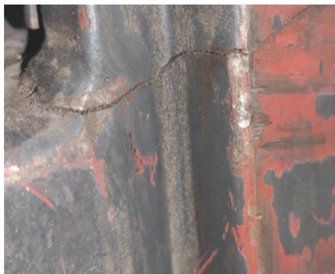
Rysunek 2. Pęknięcie materiału rodzimego masztu wózka jezdniowego podnośnikowego z mechanicznym napędem podnoszenia
