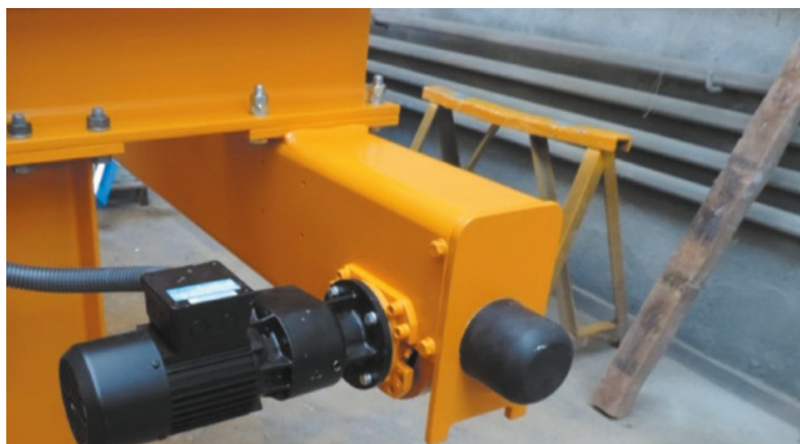
Rysunek 5. Połączenia śrubowe w konstrukcji suwnicy
