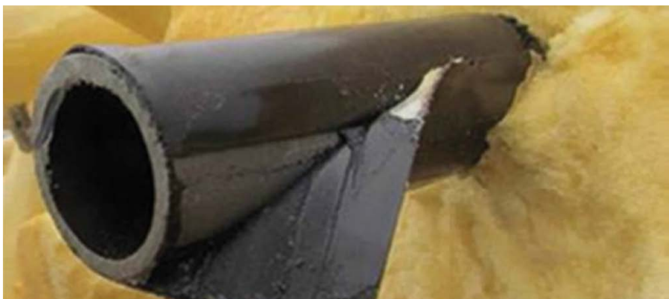
Zdj. 3 i 4. Przykłady powłoki rurociągu wykonanej w celu zabezpieczenia przed korozją pod izolacją.
