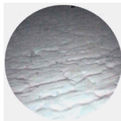
Pęknięcia w materiale płaszcza komory
