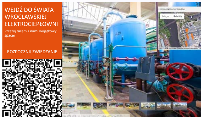
Fot. 1. Każdy beneficjent może wirtualnie odwiedzić Elektrociepłownię
