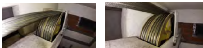
Fot. 6. Widok koła linowego dźwigu
