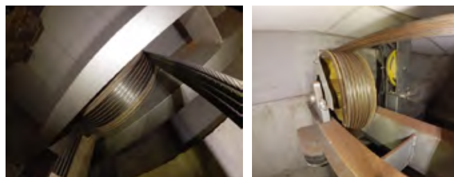
Fot. 7. Widok odbicia splotek w kole linowym oraz w kole ogranicznika prędkości
