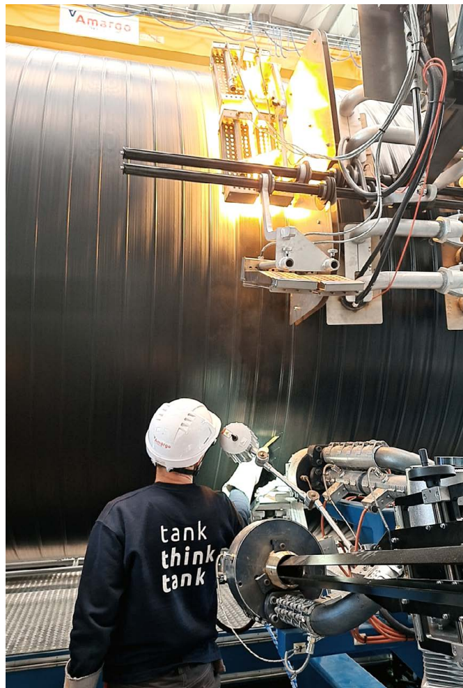
Rys. 4. Proces wytwarzania zbiornika technologią nawojową (zdj. AMARGO®)
