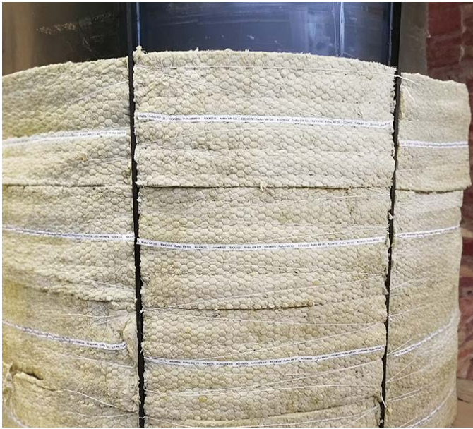
Rys. 5. Montaż izolacji na zbiorniku magazynowym – wełna mineralna połączona z jednostronną okładziną z siatki galwanizowanej (zdj. AMARGO®)
