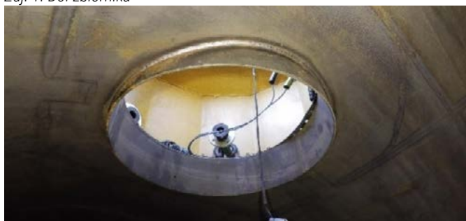
Zdj. 2. Góra zbiornika z widocznym włazem
