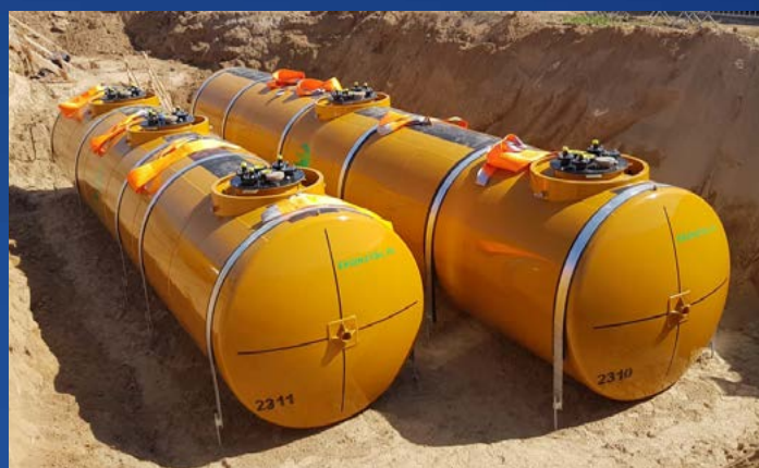
Rys. 2. Budowa stacji paliw - zbiorniki paliwa (zdj.ZBM S.A.)
