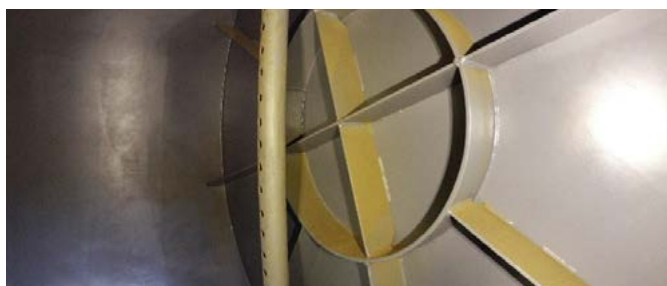
Zdj. 5. Przegroda oddzielająca komory zbiornika
