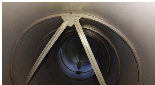
Zdj. 6. Powierzchnie wewnętrzne pokryte powłoką ochronną
