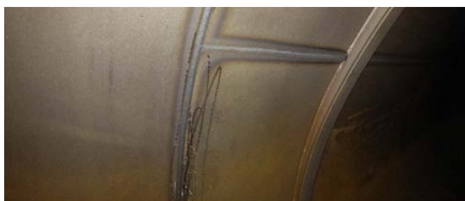
Zdj. 4. Łączenie spoiny obwodowej i wzdłużnej oraz pierścieni wzmacniający
