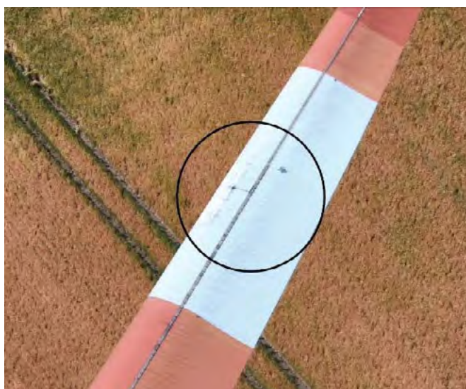
Rys. 6. Miejsce uszkodzenia i naprawy na łopacie
