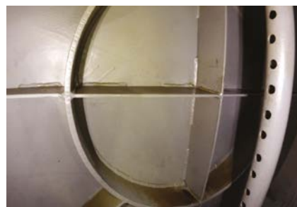
Zdj. 6. Obrazy z kamery drona przedstawiające typową rewizję wewnętrzną zbiornika podzielonego na stacji paliw (dwie komory)
