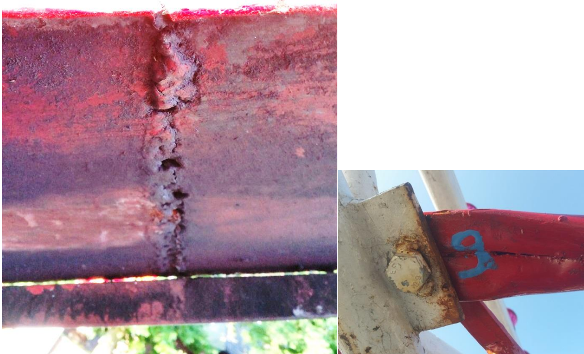
Zdjęcie 29. Przykłady nieautoryzowanych napraw.
