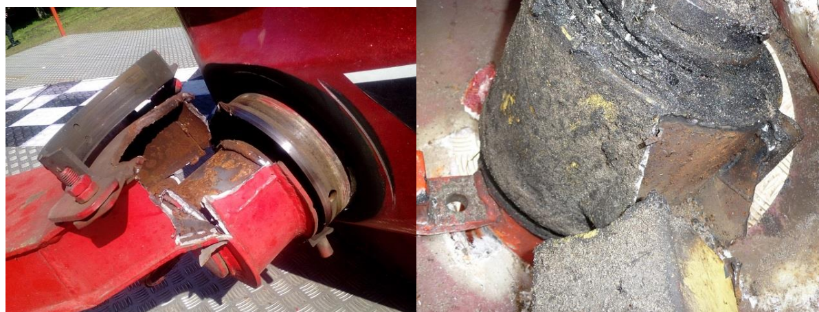
Zdjęcie 33. Pęknięcie ramienia gondoli w okolicy łożyska.
