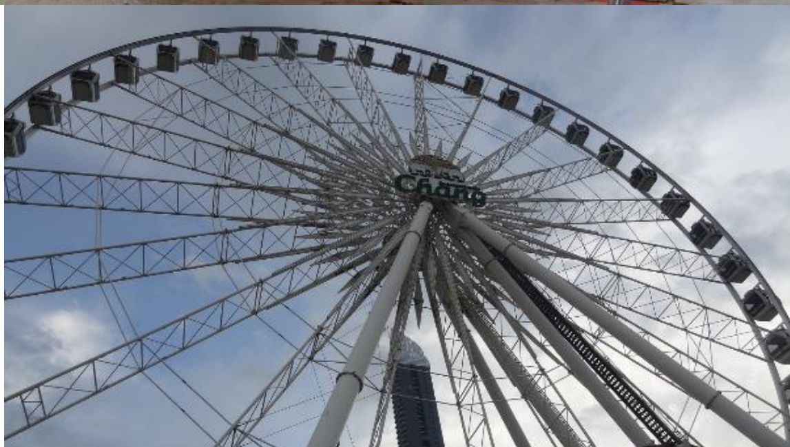
Zdjęcie 18. Przykłady rozwiązań kratowych elementów karuzel (wykonane z rur, profili zamkniętych lub walcowanych).
