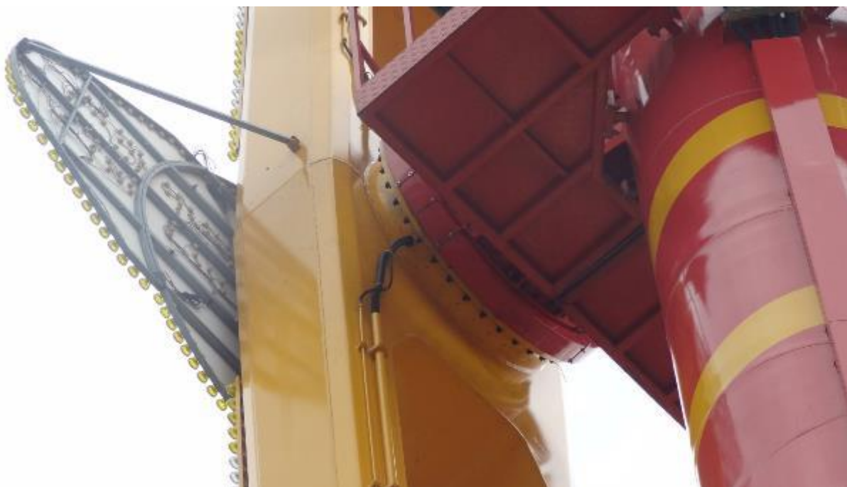
Zdjęcie 21. Przykłady konstrukcji blachownicowych.
