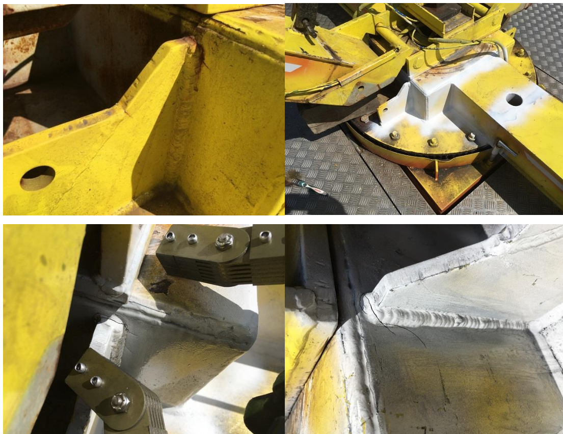
Zdjęcie 32. Pęknięcia konstrukcji.
