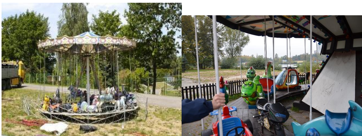
Zdjęcie 3. Karuzele dziecięce z podłogą podwieszaną.
