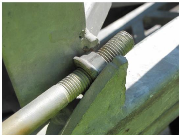
Rysunek 59. Uszkodzenia połączeń elementów podestu masztowego
