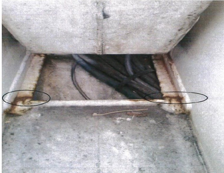
Rysunek 56. Pęknięcia zmęczeniowe kolumny podestu przejezdnego.
