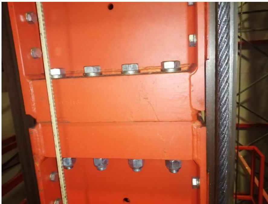
Rysunek 24. Przykład połączenia śrubowego kolumny układnicy.
