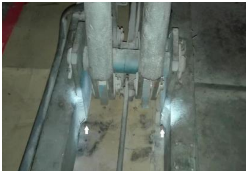
Zdjęcie 6. Spoiny na połączeniu zawieszenia i ramy kabiny.
