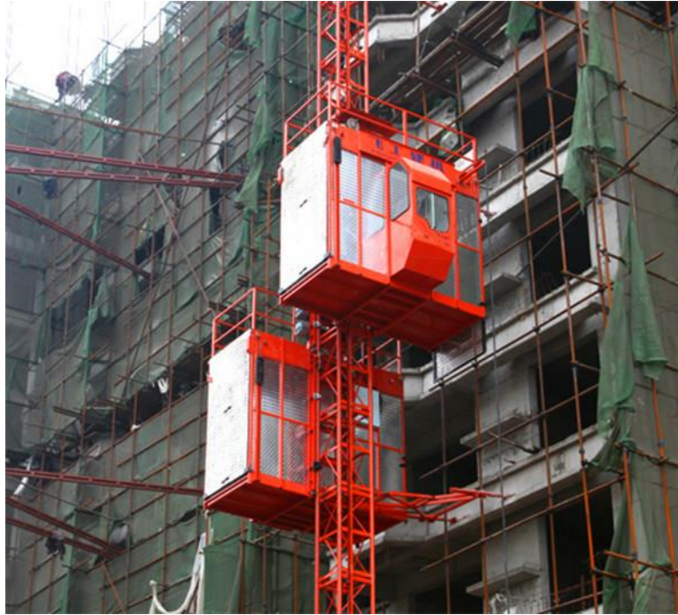
Zdjęcie 3. Dźwigi budowlane towarowo-osobowe.
