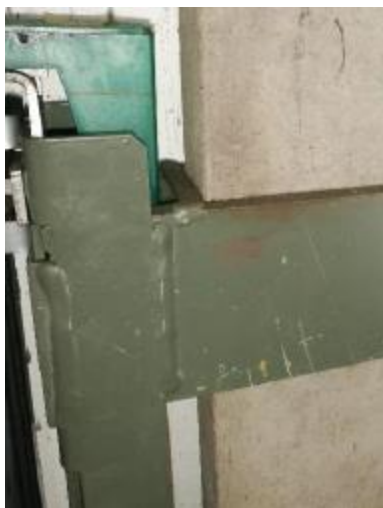
Zdjęcie 7. Spawane elementy ramy przeciwwagi.
