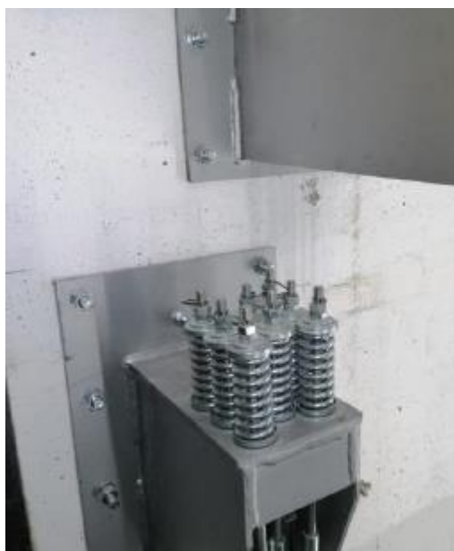
Zdjęcie 11. Montaż zawieszenia ciężarów do konstrukcji szybu.
