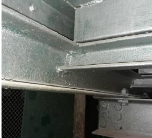
Zdjęcie 8. Połączenia spawane ramy kabiny.
