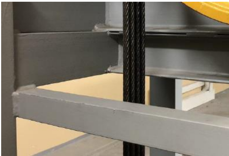
Zdjęcie 9. Połączenia nierozłączne ramy wciągarki.
