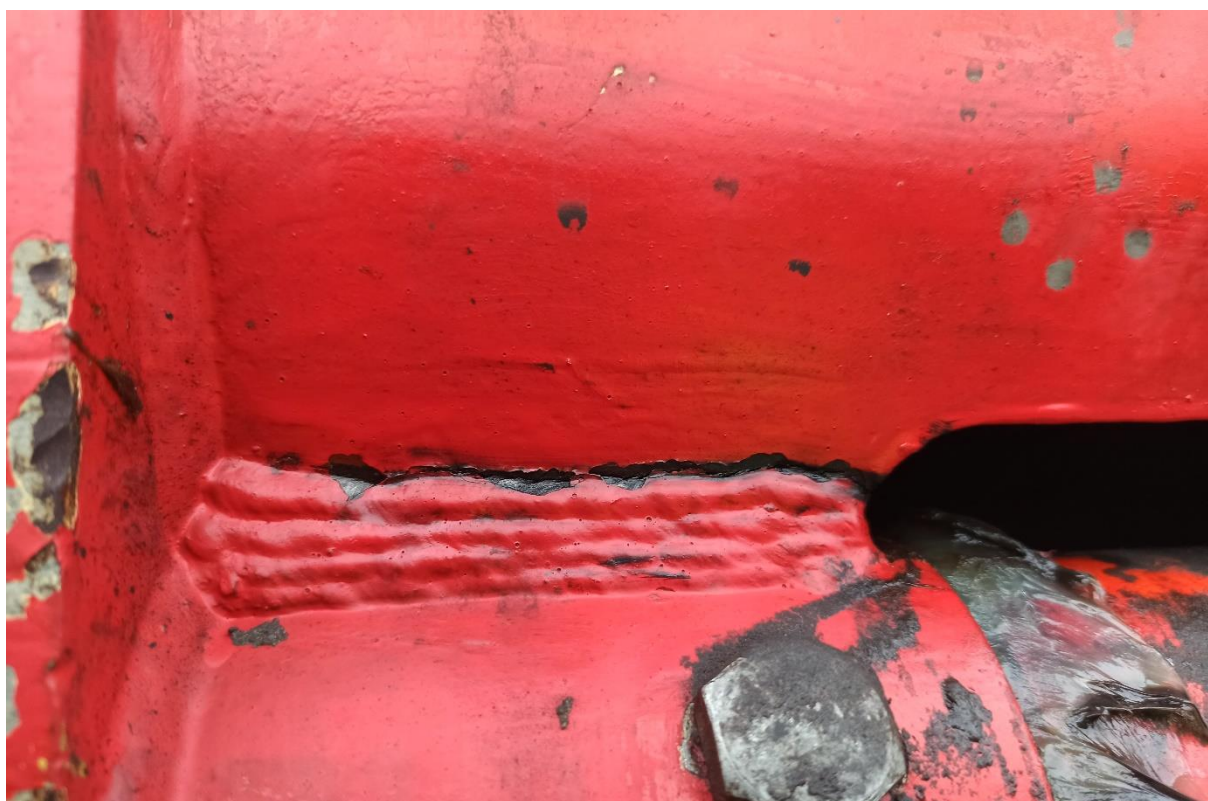
Rysunek 58. Pęknięcie mocowania wysięgnika wózka jezdniowego podnośnikowego z mechanicznym napędem podnoszenia specjalizowanego ze zmiennym wysięgiem.
