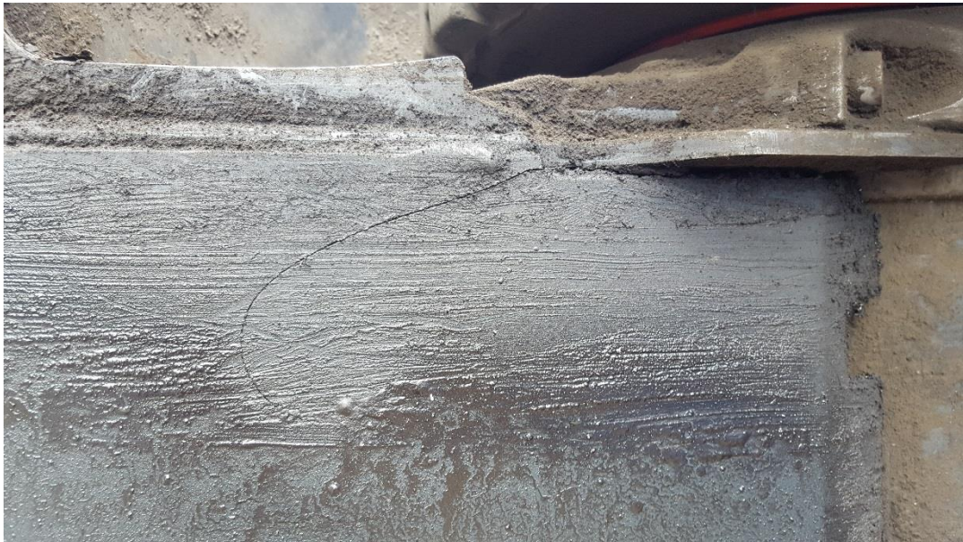
Rysunek 31. Pęknięcie ramy wózka jezdniowego podnośnikowego z mechanicznym napędem podnoszenia.
