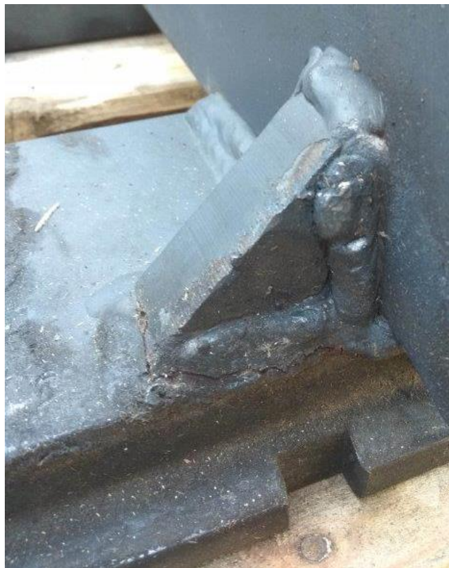
Rysunek 45. Pęknięcie płyty czołowej (karetki) wózka jezdniowego podnośnikowego z mechanicznym napędem podnoszenia w miejscu nieautoryzowanej naprawy.
