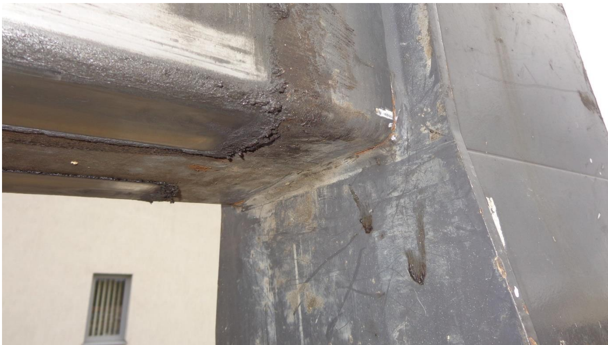
Rysunek 53. Pęknięcie wysięgnika wózka jezdniowego podnośnikowego z mechanicznym napędem podnoszenia specjalizowanego ze zmiennym wysięgiem.
